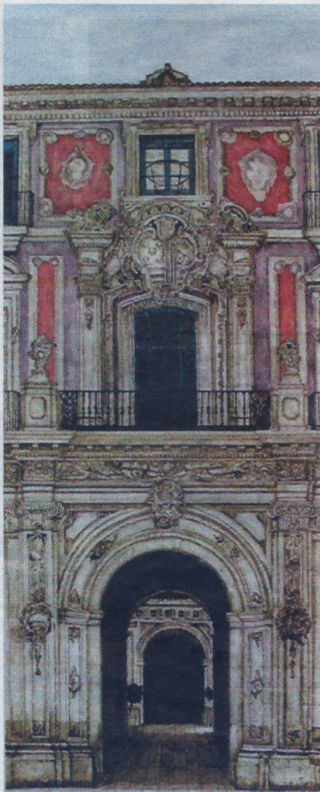
Fachada del palacio episcopal, de Heredia Gil.
